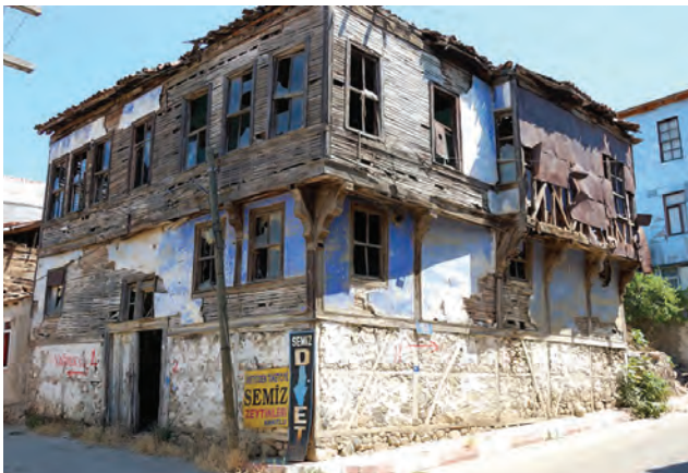
Fotoğraf 2- Evlerin üst kat cephelerinde bağdadi tekniği ( http://www.yalovakentmuzesi.gov.tr ) / Bağdadi technique used in the facades of the upper floors of the houses ( http://www.yalovakentmuzesi.gov.tr )
