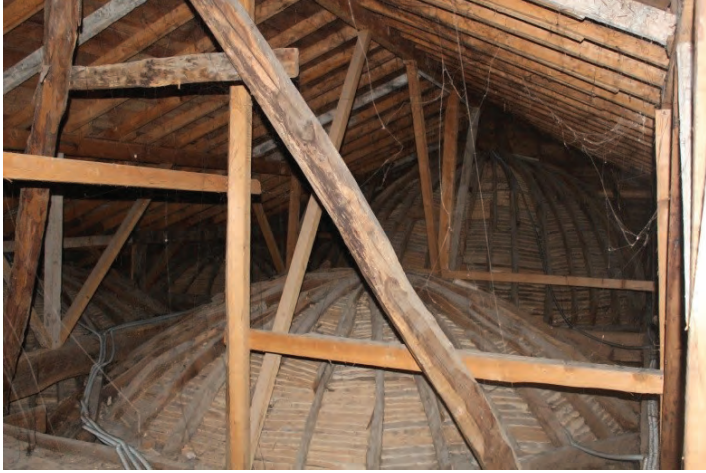
Fotoğraf 5 – Bağdadi kubbelerin çatı makasları arasına yerleştirilişi (Mukaddes Ataman) / The placement of the bağdadi dome in-between the roof trusses (Mukaddes Ataman)
