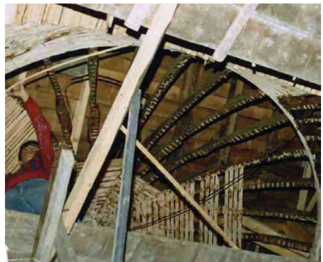
Fotoğraf 3 – Bağdadi kubbenin bağdadi çitalarının çakılması (Vakıflar Genel Müdürlüğü Arşivi'nden) / Nailing the timber laths of the bağdadi dome (From the Archives of the General Directorate of Foundations)
